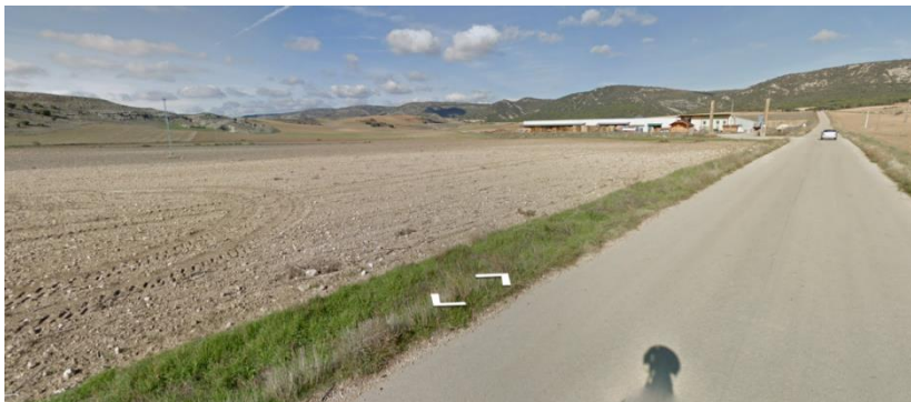
Vista este de la línea aérea que suministra electricidad al campamento de Los Palancares.
