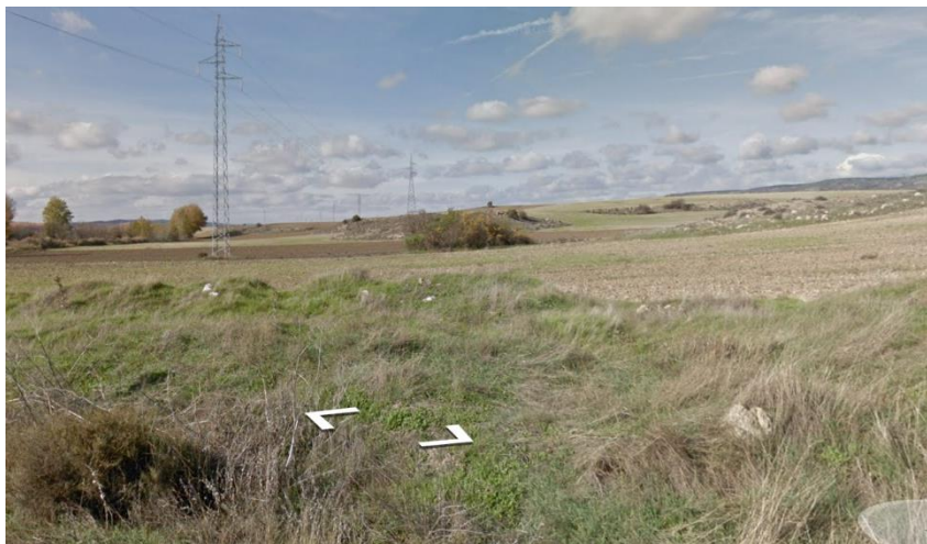
Vista este de la línea eléctrica de evacuación de energía producida en la cogeneración de PINASA.
