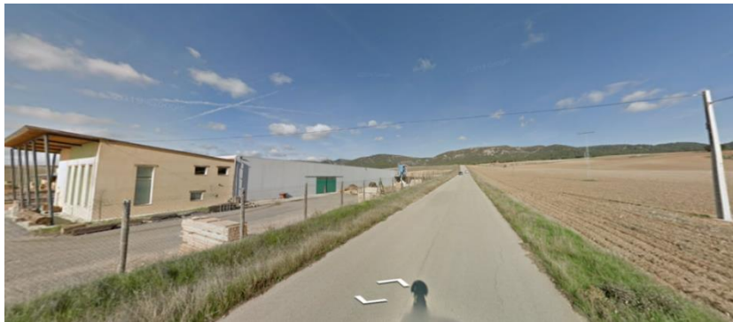
Vista este de la línea de teléfono que da servicio a la Fábrica de Maderas.
